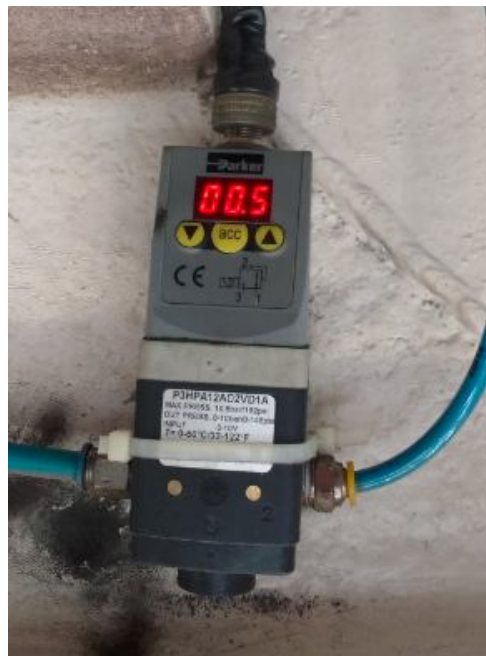
Figura 2.7 – Válvula reguladora de pressão proporcional.
