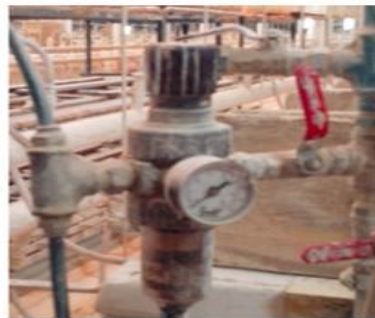
Figura 1.5 – Esquema e foto de válvula reguladora de pressão.
