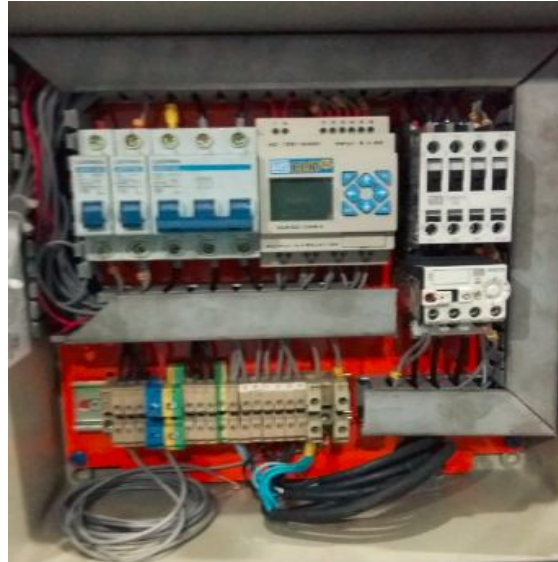
Figura 2.4 – Painél com CLP disponível na indústria de louças sanitárias onde o teste foi realizado.
